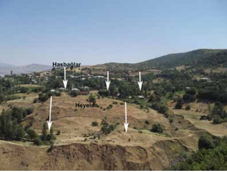
Foto 6. Adaklı güneybatısında yer alan Hasbağlar köyünde yağış ve yeraltı suyuna bağlı olarak heyelanlar görülmektedir
