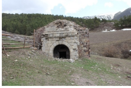
Fotoğraf 13. Demirkapı Köyü Hidirellez Kilisesi Batı Cephesi
