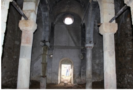
Fotoğraf 14. Güzeloluk Köyü Ioannes Prodromos Kilisesi Batı duvarında Çan kulesine çıkış sağlayan merdiven izleri
