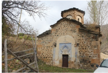
Fotoğraf 10. Alpulu Mahallesi Kilisesi Batı Cephesi
