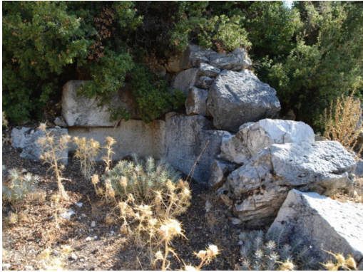
Abb. 5: Polygonales Mauerwerk
