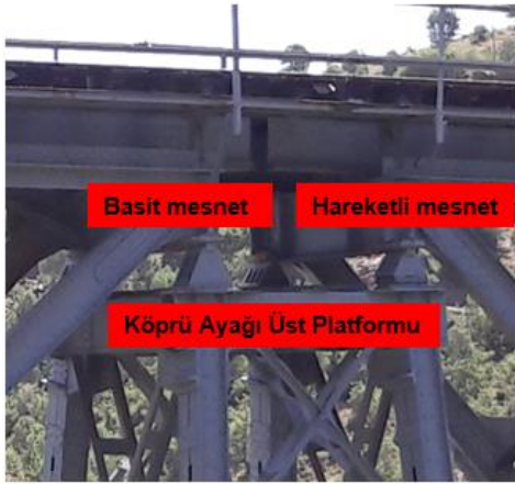
Şekil 8: Köprü ayağı mesnetleri.
