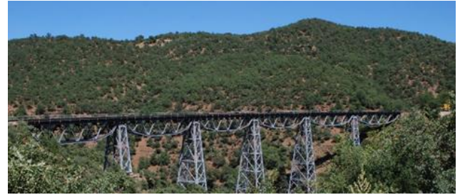
Şekil 1: 199+325 Çelik demiryolu köprüsü genel görünümü.
