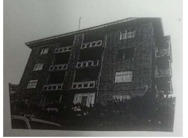
Şekil 1. Taşıyıcı sistem fotoğrafı (Structural System-photo)
