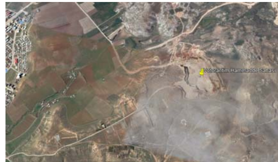
Şekil 1. Votorantim çimento ocağının lokasyonu
