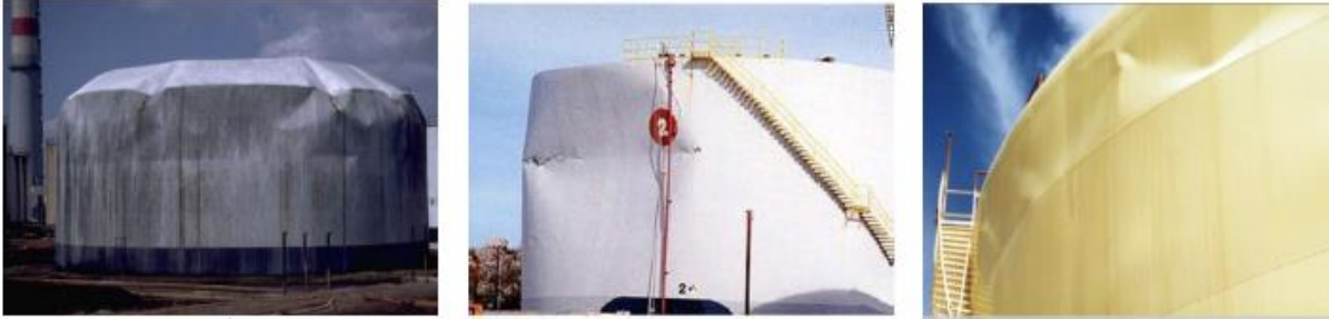
Şekil 1. Çalkalamanın neden olduğu tank duvarı ve üst kısmı hasarlıdır [10]
