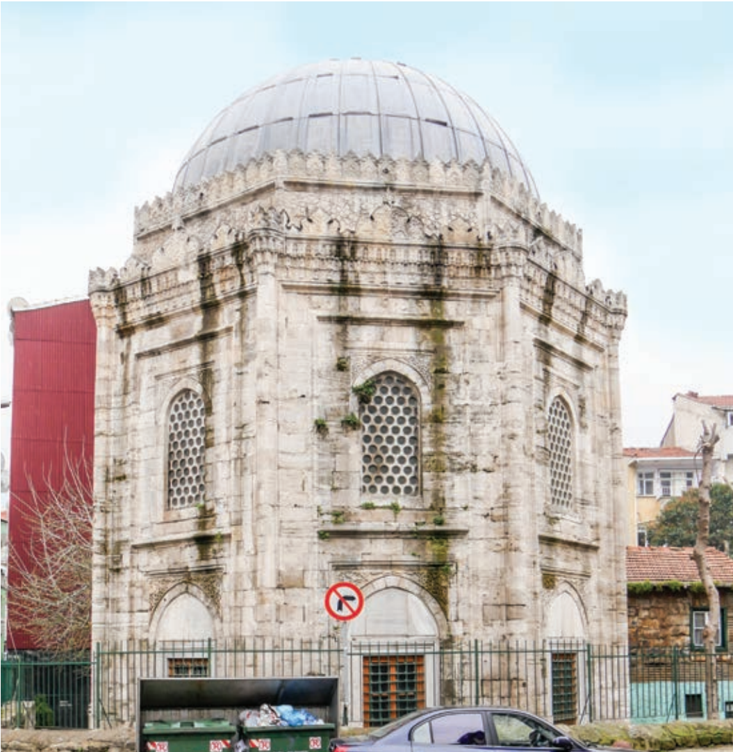
Şekil 17. 2009 yılında İBB KUDEB tarafından onarılan Hüseyin Paşa Türbesi'nde yapılan koruma uygulaması, önerilen Aktif / Mobilize Koruma Modeli kapsamında değerlendirilebilir. (Kaynak: KUDEB Taş Eğitim Atölyesi, 2009)
