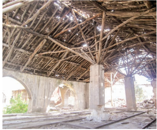
Şekil 18. Ahşap üst örtü
