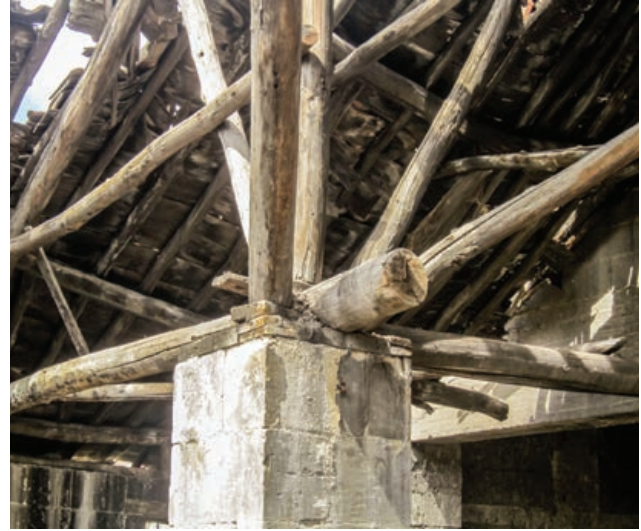
Şekil 19. Çatı mesnet noktasına bakış
