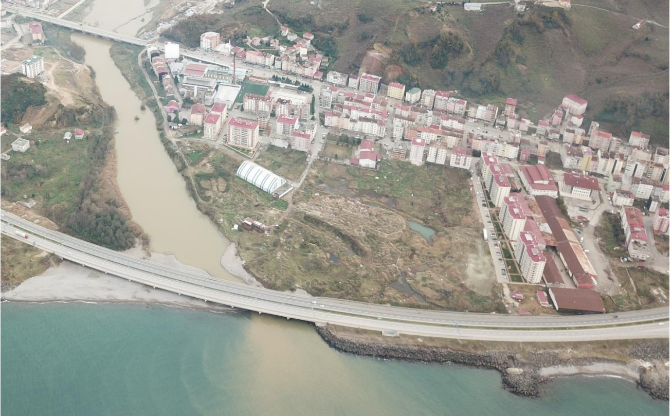
Fotoğraf 10: Deltanın Batı Yarisında, Yer Yer Su Birikintilerinin Gözlendiği Kısımda Yükselen Çok Katlı Binalar (Drone Çekim, Cüneyt AKTAŞ, 2017)
