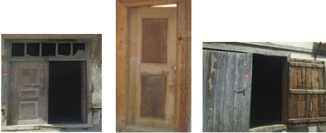
Şekil 24. Ali Pektaş Evi'ne ait ahşap kapı görüntüleri [13]
