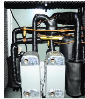
Şekil 2. Isı pompasına ait a) toprak devresi b) ısı pompası ünitesi (Heat pump cycle of a) ground b) heat pump unit)
