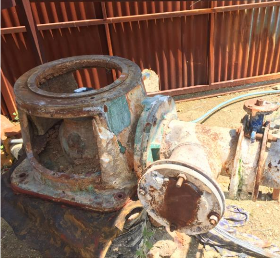
Şekil 8. 1 nolu kuyu başından gözlenen kabuklaşma.
