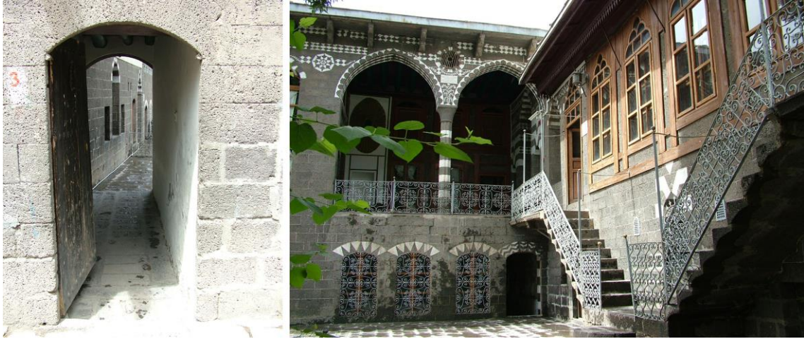
Şekil 3. Geleneksel konutlarda avlu ile sokak bağlantısı (solda) ve kalın taş duvarlar arkasındaki mekânların (yazlık ve ilkbaharlık) avluya bakan yüzündeki hünerli taş, ahşap ve demir işçiliğinden bir görünüm (sağda)
