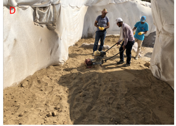
Resim 20. Mardinike Külliyesi Yapı Kalıntılarının Su Altında Korumasına Yönelik Uygulamaları, Resim 20A-20B: Jeotekstil Keçe Kalıntılarının Yüzeyine İki Kat Olarak Serilmesi Uygulaması, Resim 20C-20D: Tabakalar Halinde Doldurulan Koruma Dolgu (Mil Kumu) Uygulaması (Yazar Arşivi)
