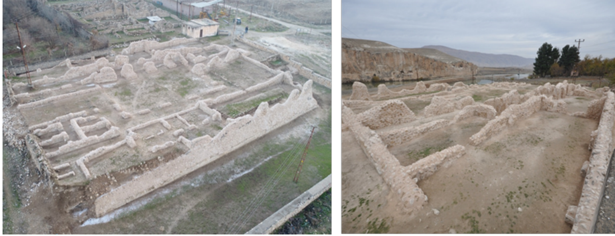
Resim 18. Mardinike Külliyesi Yapı Kalıntılarının Restorasyon Uygulamaları Sonrası Görünümü (Yazar Arşivi)
