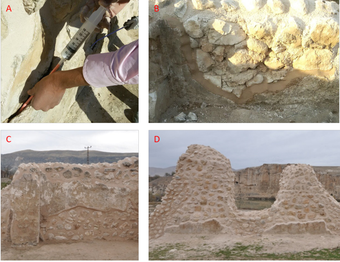
Resim 17. Mardinike Külliyesi Siva Kalıntılarının Sağlamaştırılması, Resim 17A: Siva ile Arka Taşıyıcı Yüzey Arasında Oluşan Ayrılma Harç Enjeksiyonu Uygulanması, Resim 17B: Dökülen Kenarlarını Duvara Bağlamak ve Güçlendirmek için Bordür Harcı Uygulanması, Resim 17C-17D: Siva Kalıntılarının Sağlamaştırılması Uygulamaları Sonrası (Yazar Arşivi)
