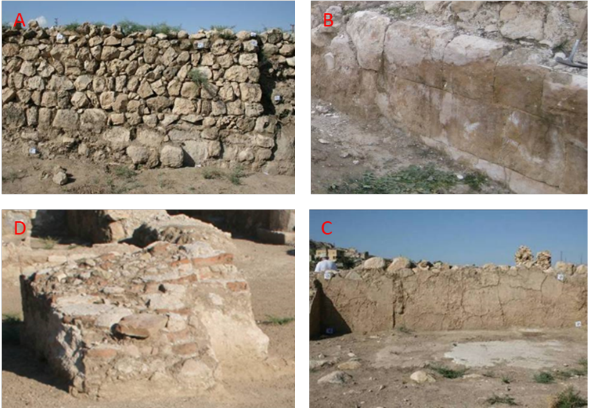
Resim 5. Mardinike Külliyesi, Resim 5A: Moloz Taş Malzeme Kullanımı, Resim 5B: Kesme Taş Malzeme Kullanımı, Resim 5C: Tuğla Malzeme Kullanımı, Resim 5D: Sıva Kullanımı (Yazar Arşivi)
