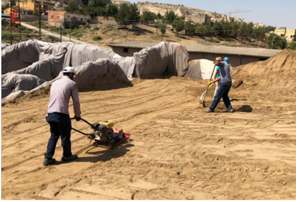
Resim 20. Mardinike Külliyesi Yapı Kalıntılarının Su Altında Korumasına Yönelik Uygulamaları, Resim 20A-20B: Jeotekstil Keçe Kalıntılarının Yüzeyine İki Kat Olarak Serilmesi Uygulaması, Resim 20C-20D: Tabakalar Halinde Doldurulan Koruma Dolgu (Mil Kumu) Uygulaması (Yazar Arşivi)
