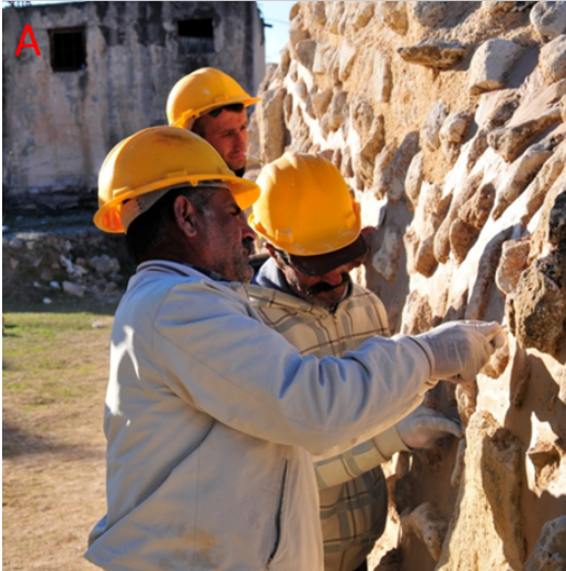
Resim 15. Mardinike Külliyesi Yapı Kalıntılarının Duvar Örgülerinde Derz Onarımları, Resim 15A. Derz Onarımları Uygulamaları, Resim 15B. Derz Onarımları Uygulamaları Sonrası (Yazar Arşivi)
