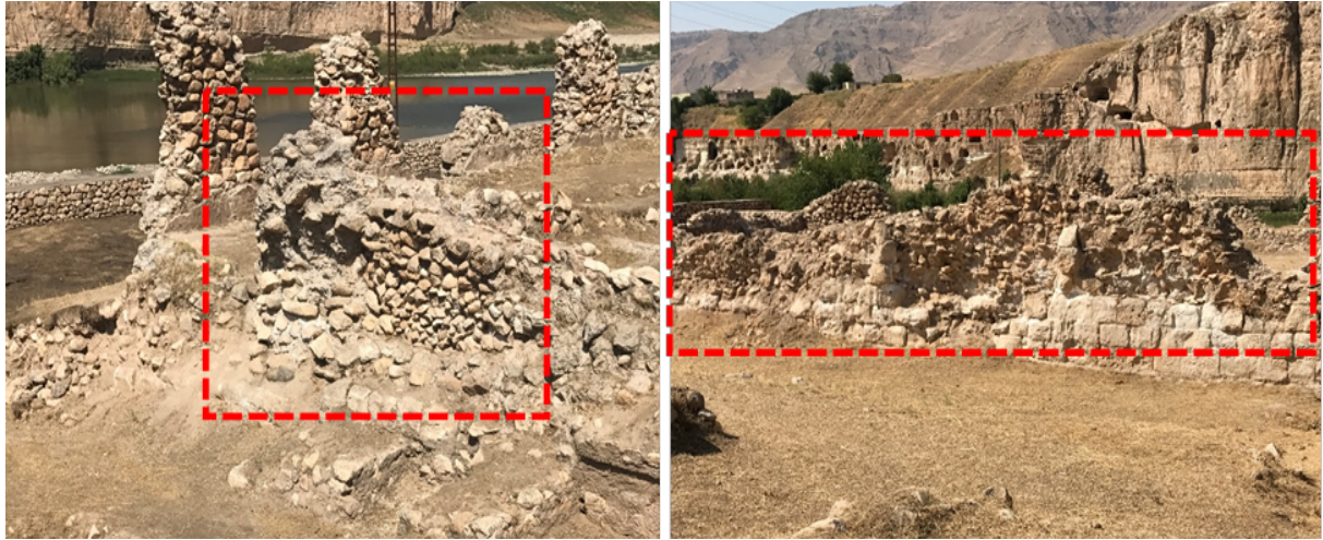
Resim 7. Mardinike Külliyesi Duvar Örgülerinde Bölgesel ve Birim Eleman Kayıpları Örnekleri (Yazar Arşivi)
