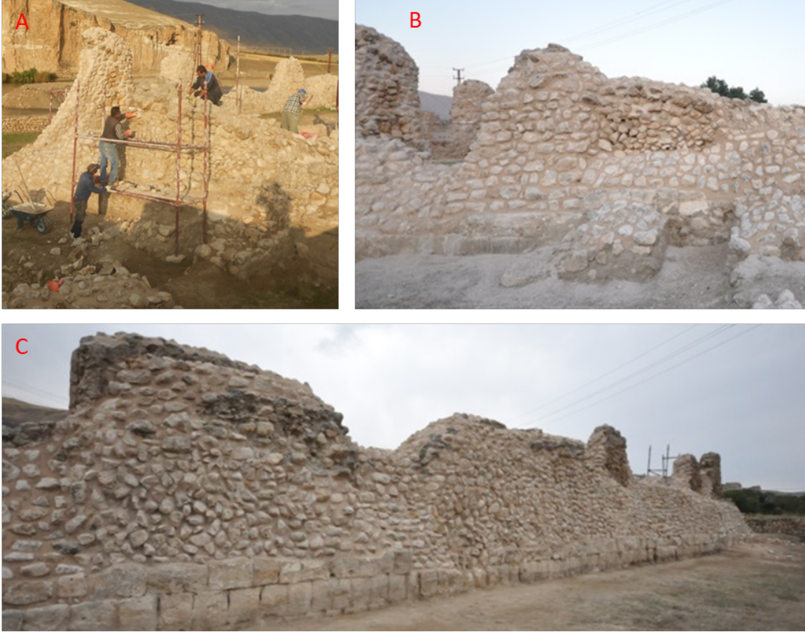
Resim 13. Mardinike Külliyesi Yapı Kalıntılarının Duvar Örgülerindeki Bölgesel ve Birim Eleman Kayıplarının Tamamlanması, Resim 13A: Duvar Örgülerindeki Tamamlama Uygulamaları, Resim 13B-13C: Duvar Örgülerindeki Tamamlama Uyguları Sonrası (Yazar Arşivi)
