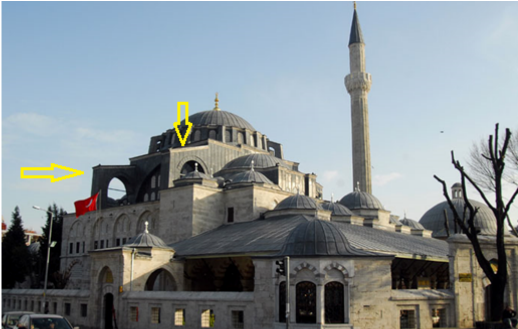
Şekil 3. Kılıç Ali Paşa Camisinin genel bir görünüşü ve kemerli payandaları [8]
