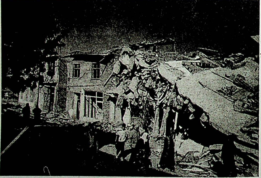
Foto:13-Depremden hasar görmüş, betonarme yığma binalar.
