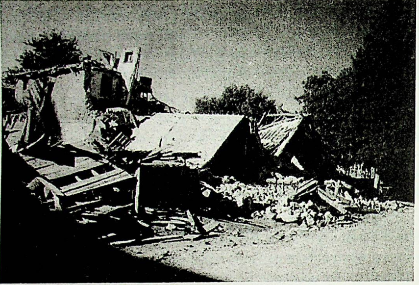
Foto:12-Depremden hasar görmüş kagir yapılı bir bina
