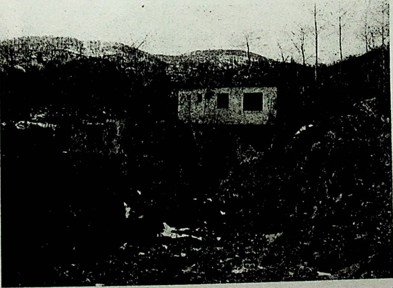
Foto : 6- Gölyanı Gölü'nün 100 m. kadar batısındaki beton binalarda meydana gelen önemli hasarlar. (Foto 1' de yer alan bina ve blokların yakından görünüşü).
