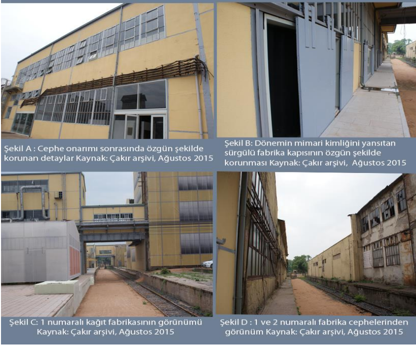
Şekil 3. Onarım sonrası SEKA Selüloz ve Kağıt Fabrikasının cephelerinden görünüm
