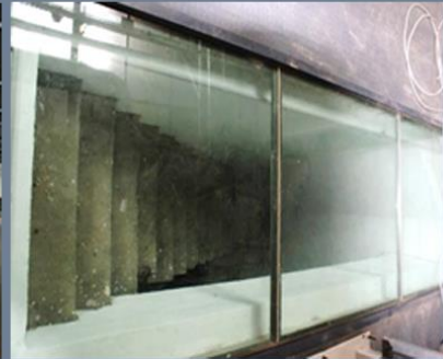
Şekil D: Özgün merdivenin korunması için yapılan cam döşeme Kaynak: Çakır arşivi, Ağustos 2015
