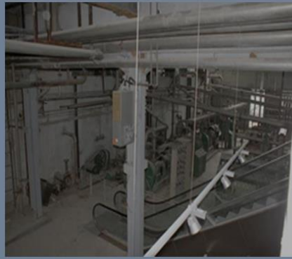
Şekil A: Yeni dolaşım yolu için yapılan yürüyen merdiven Kaynak: Çakır arşivi, Ağustos 2015
