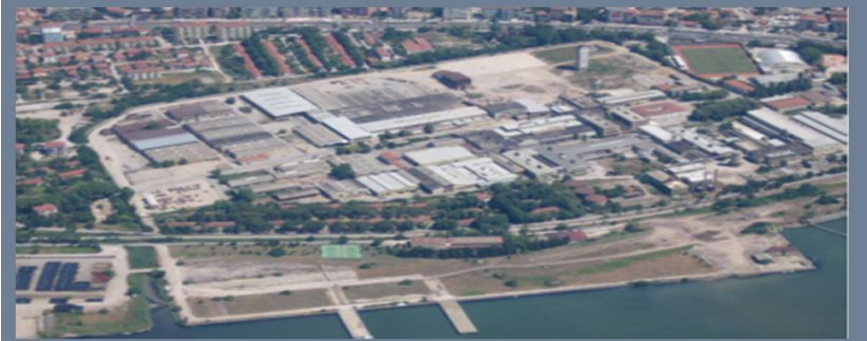
Şekil A: SEKA Bölgesi dönüşüm öncesi görünüm Kaynak: Kocaeli Büyükşehir Belediyesi Arşivi, 2004
