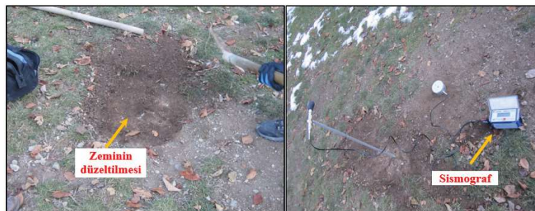
Şekil 5. Zeminin düzeltilmesi ve Instanetel marka Minimate Blaster model Sismografin kurulumu
