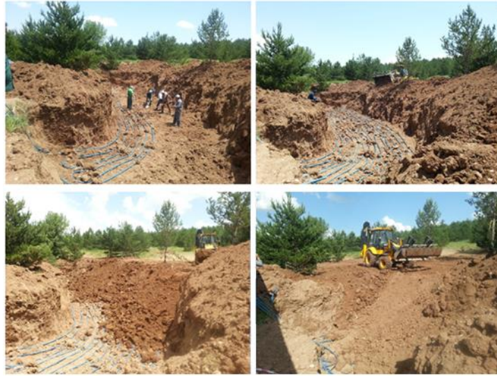
Şekil 3. Toprak altı ısı deęiştiricisinin 2,5 m derinliğe yerleřtirilme ařamaları.
