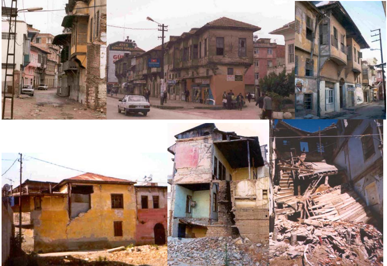
Şekil 15 . Sokak dokusu örnekleri ve deprem sonrası yapıların durumu (Examples of street texture, and the situation after the earthquake)
