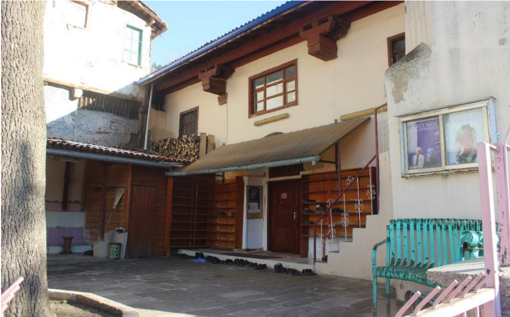
Resim 2. Üzümlören Ulu Camii Kuzey Cephe
