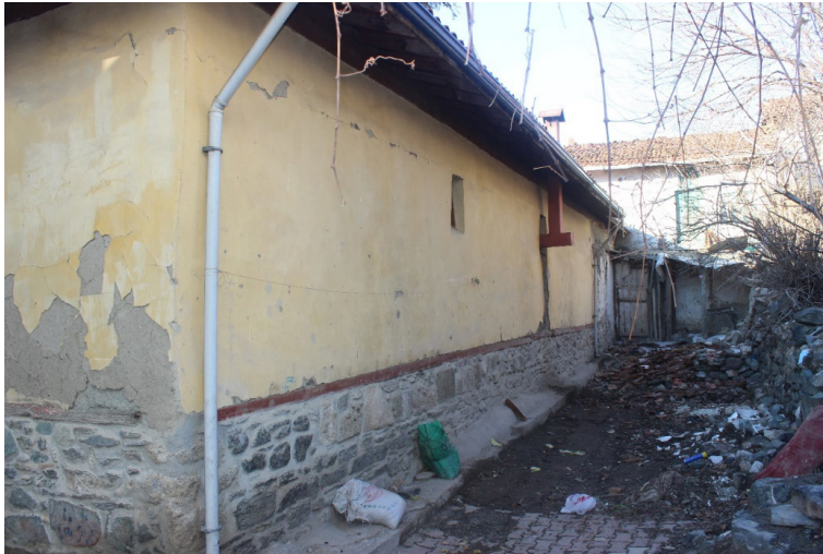
Resim 4. Üzümören Ulu Camii Doğu Cephe
