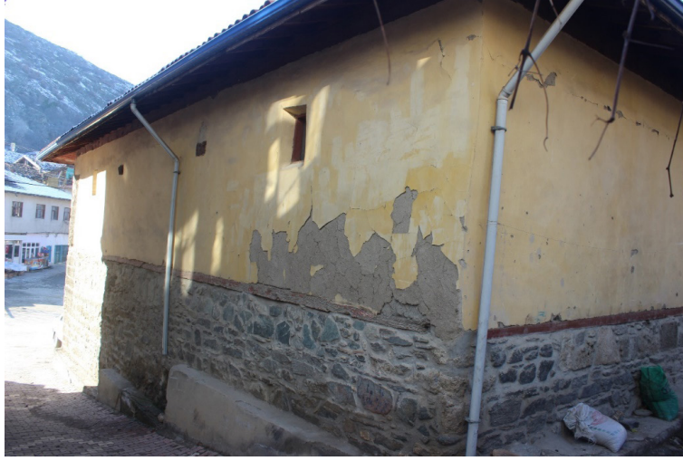
Resim 3. Üzümören Ulu Camii Güney Cephe
