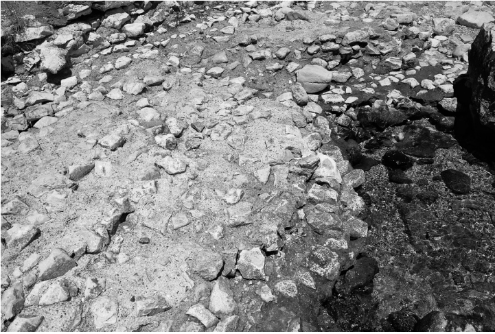
Fig. 4 Hidrolik dolgu betonu
