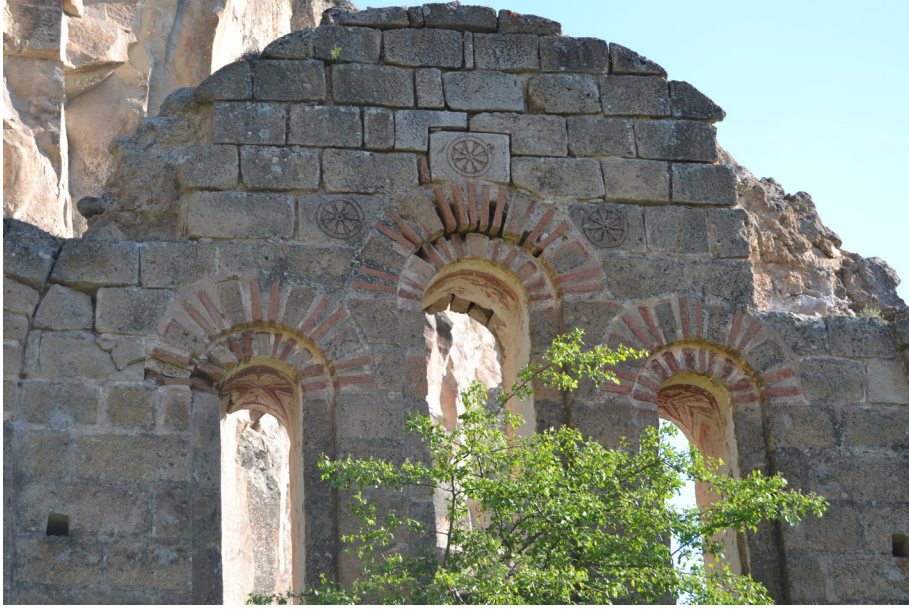
Resim 17. Karagedik Kilise, Kuzey Cephe, Kemerlerdeki Tuğla Kullanımı, Kuzeyden Bakış (2013)
