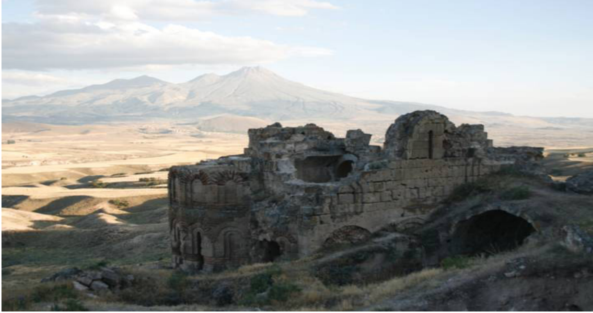
Resim 6. Çanlı Kilise, Kuzeydoğudan Bakış (2010).
