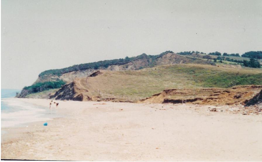
Foto 4. Yeniçam köyünde dalga aşındırması sonucu meydana gelen heyelan
