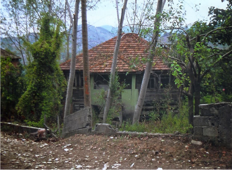
Foto 5. Topağaç köyü Tepecik mahallesinde (Ayancık) heyelan nedeniyle terk edilen ahşap konut
