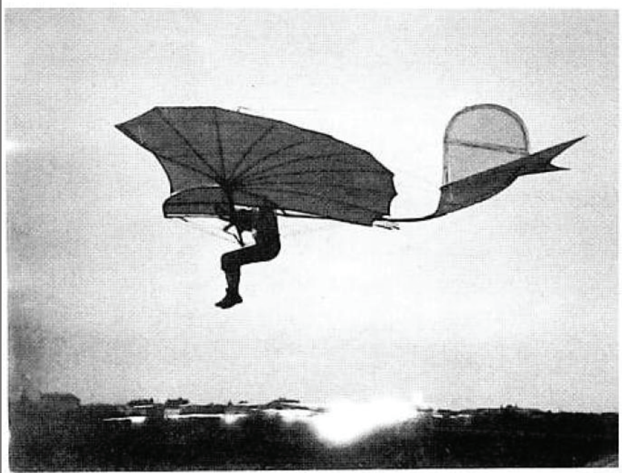
Resim 1. Otto Lilienthal'in Tasarladığı Tahta İskeletli ve Bez Kaplama Planör [2]
