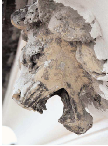
Şekil 7 ve 8. Roma çimentosu bağlayıcılı dökümlerde elde edilebilen narin detay niteliği diğer çimento bağlayıcılı harçlara göre çok daha yüksektir. Her iki örnekte bezemenin üzerine kaplayarak detay niteliğini bozan geç tarihli yüzey boya müdahaleleri kısmen temizlenmiştir. ( Roman Cement - Brochure , 2005: 11, 14).
