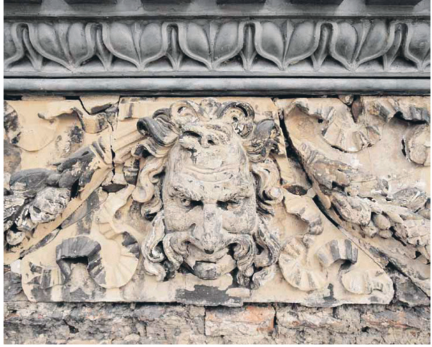
Şekil 18. Farklı parçaların bir araya getirilmesiyle oluşturulmuş öndöküm bezeme panelinden detay. Kir ve boya kalıntıları detayları belirsiz hale getiriyor. Şeklin üst tarafında yer alan korniş ise farklı bir malzemeyle, çinko levha metalden üretilmiştir ( Roman Cement - Brochure , 2005: 4).
