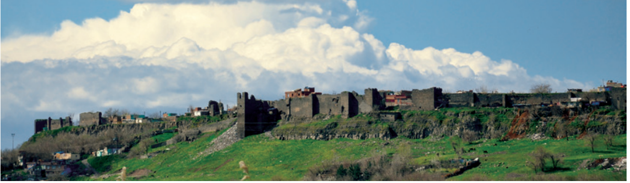
Şekil 4. Surların doğu görünüşü
