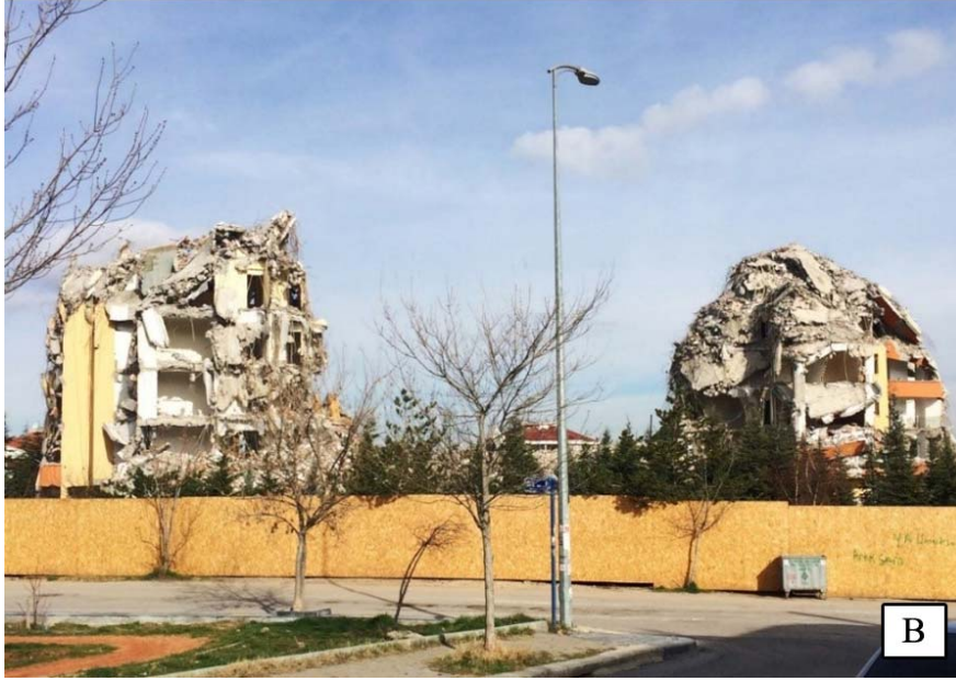
Şekil 2. Yıkımın erken (A) ve geç (B) fazları (Early [A] and late [B] phases of the demolition)
