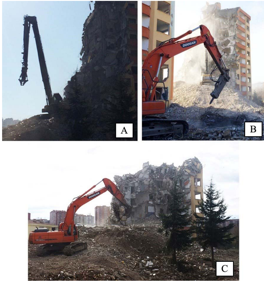
Şekil 1. Yıkım araçları hidrolik parçalayıcı (A), hidrolik kırıcı (B), kepçe (C) (Demolition Machines Hydraulic pulverizer [A], Hydraulic breaker [B], Excavator [C])
