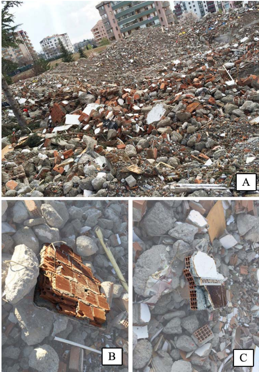
Şekil 4. Yıkım sonrası tuğla içeren karışık atıklar (A), tuğla duvar parçaları (B) ve (C) (Mixed debris containing brick pieces [A], brick wall sections [B] and [C])
