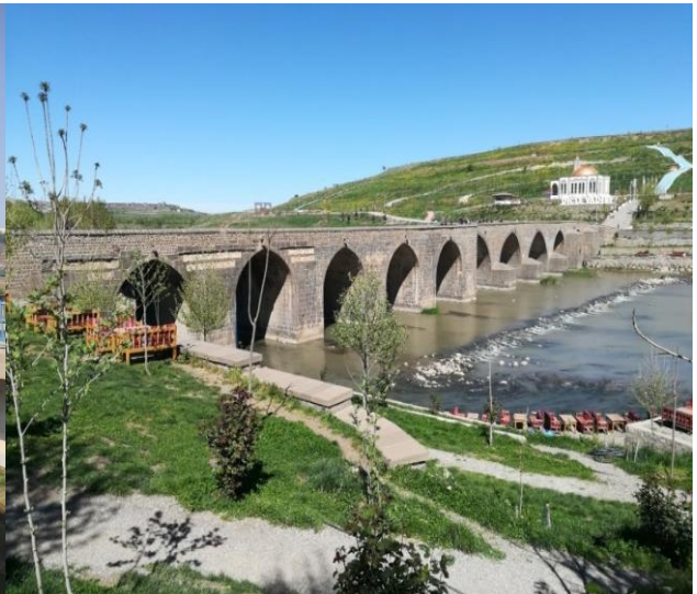
Şekil 7. Tarihi On Gözlu Köprüsü
