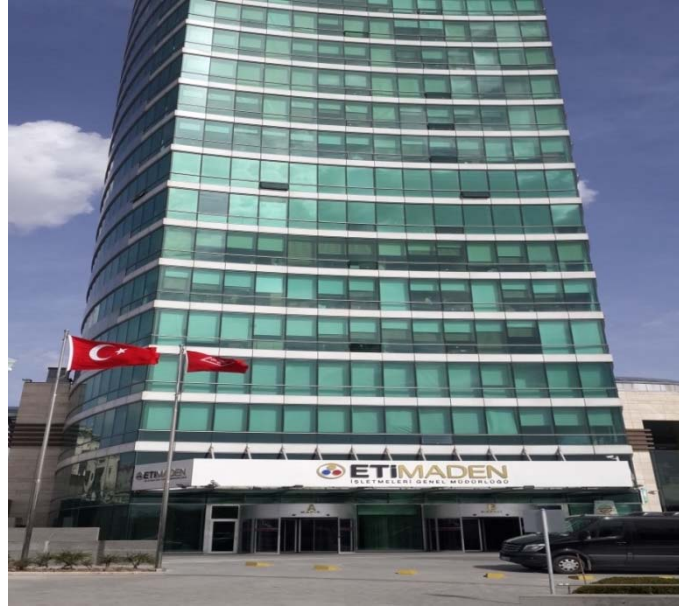
Etimaden İşletmeleri Genel Müdürlüğü Binası (20 Mart 2018)
