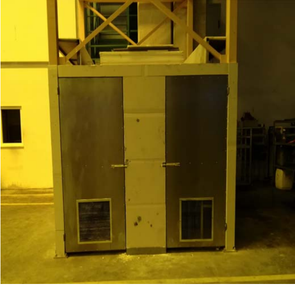
Şekil 3. İyileştirme sonrası basınçlı gaz tüpleri için oluşturulan depolama alanı (Storage area for pressurized gas cylinders after improvement)
