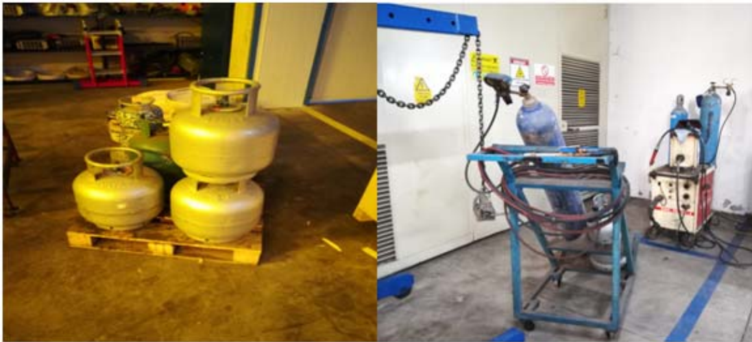
Şekil 2. İyileştirme öncesi basınçlı gaz tüplerinin yerleşimi (Location of pressurized gas cylinders before improvement)
