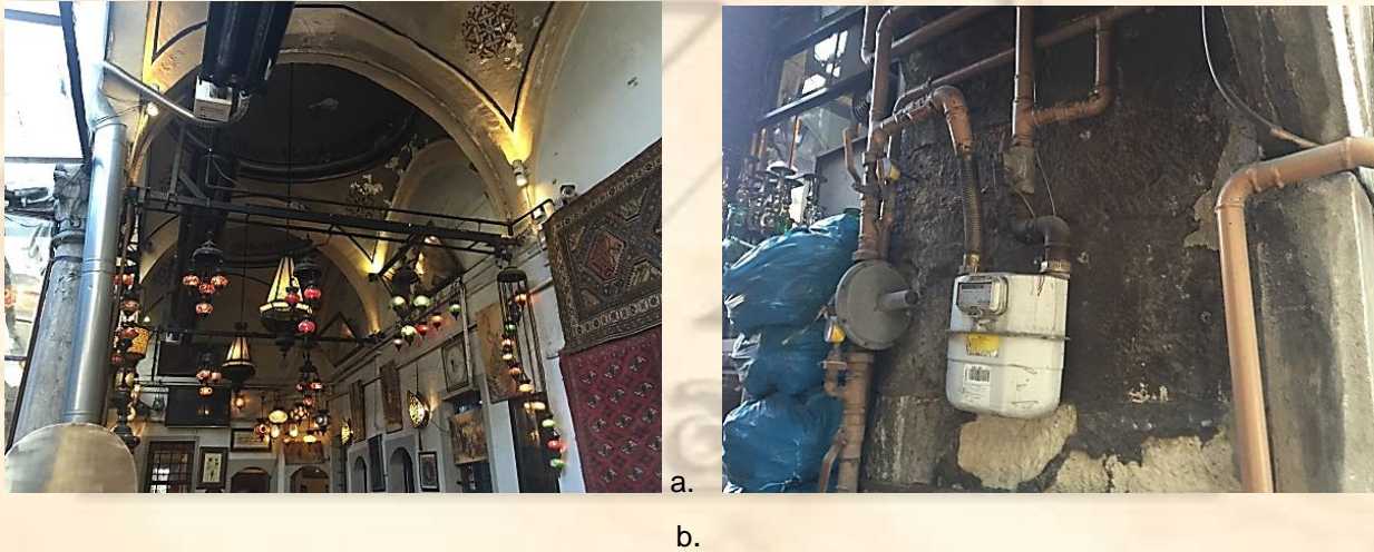
Şekil 6. Çorlulu Ali Paşa Medresesi'nin güncel işlevinden kaynaklanan yapının iç mekânında aşırı tesisat yükü ve ticari eşyalarla kültürel miras algısının yok edilmesi (Öztürk, 2017).
