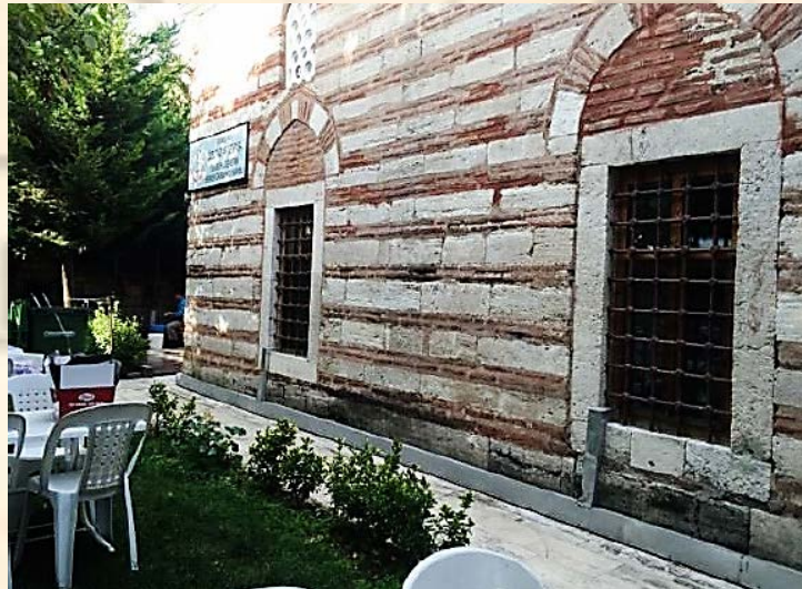
Şekil 5. Gazi Kara Ahmet Paşa medresesinin yurt olarak kullanımından dolayı cephede tesisat kanalı görülmektedir (Öztürk, 2017).
