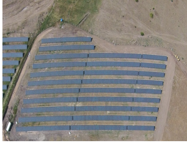
Şekil 4. Albatur enerji GES tesisi.
