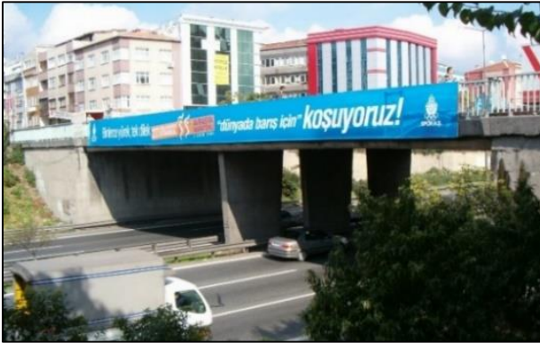
Şekil 5. K5 Köprüsü, 2006 (Kaynak: F. Pakdamar)
