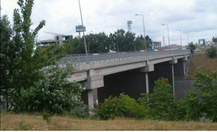
Şekil 16. K17 Köprüsü, 2006 (Kaynak: F. Pakdamar)
