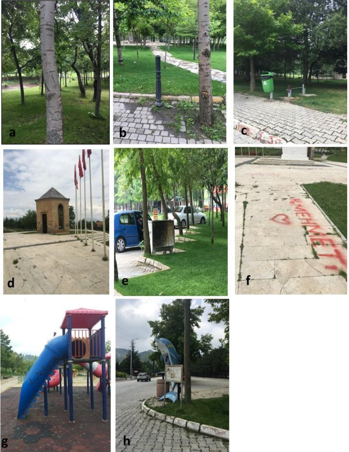
Şekil 3. Gökçay Mesire Alanındaki donatı elemanlarında karşılaşılan vandalizm zararlarına örnekler (a: Ağaç yüzeyindeki zararlar; b: Zarar görmüş aydınlatma elemanı; c: Kullanılamaz duruma gelmiş oturma birimi; d: Zarar görmüş yapısal donatılar; e: Zarar görmüş çöp kutusu; f ve g: Yazı yazılmış ve resim yapılmış donatı elemanları; h: İşaret levhasının işlevsiz durumu)
