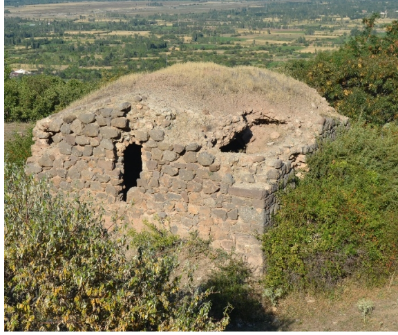
Görsel 17. Yaylabası kilisesi batı ve güney cepheleri genel görünüm
