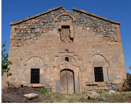
Görsel 2. Değirmenliköy kilisesi batı cephesi genel görünümü
