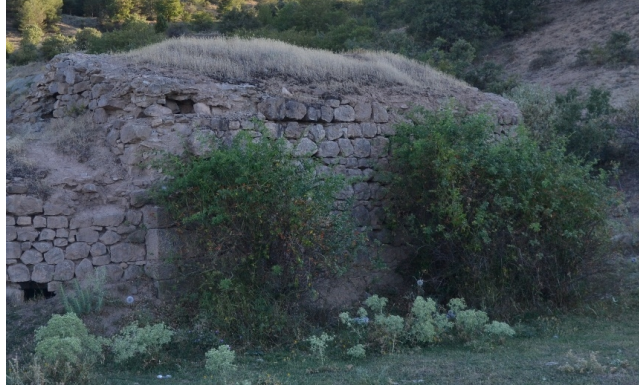
Görsel 18. Yaylabası kilisesi kuzey cephesi genel görünüm
