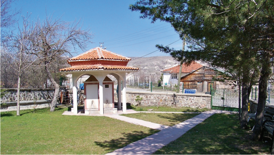
Fot. 3: Peçenek Camisi kuzey avlu ve şadırvandan genel görünüş.
