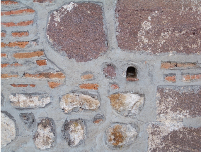
Fot. 9: Peçenek Camisi batı duvarındaki kuş evi.
