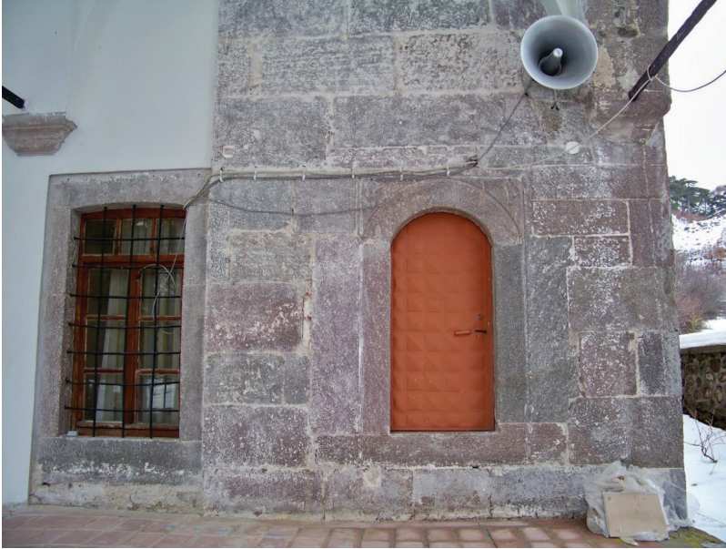
Fot. 11: Peçenek Camisi, son cemaat yeri batı kenarındaki minare kapısı.
