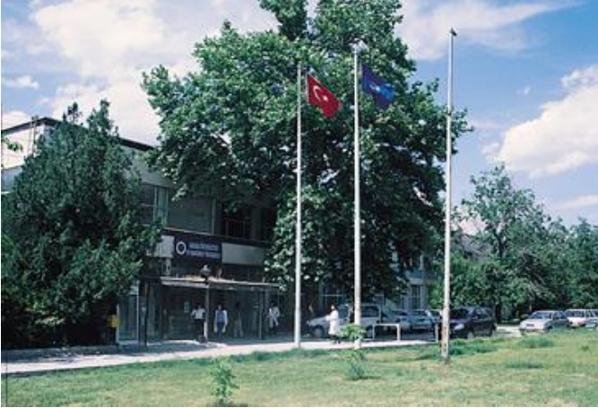
Şekil 3. Ziraat Fakültesi Ev Ekonomisi Yüksekokulu Binası Dışkapı Yerleşkesi, 1995 (Ayyıldız, 2015)
