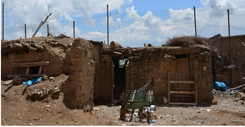
Resim 23 – Kuzey Cephesi Görünümü
