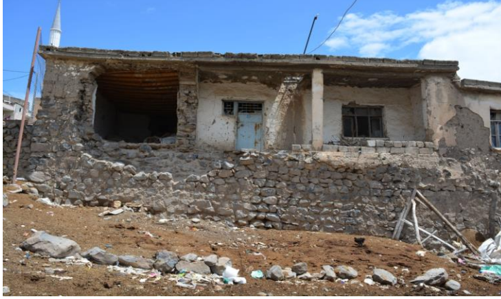
Resim 24 – Batı Cephesinden Görünüm
