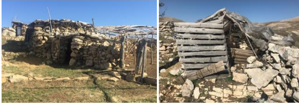
Şekil 9. Yığma taş sistemle inşa edilmiş yapılar, yavru/hasta hayvanların bakımı için özel alanlar.
