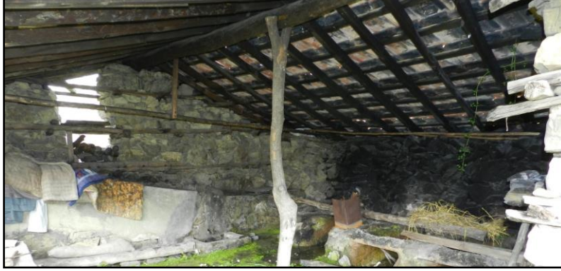
Görsel 17. Çatı iskelet sistemi.
