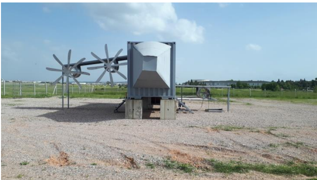
Şekil 10. Motorların montaj çalışmaları [11].
