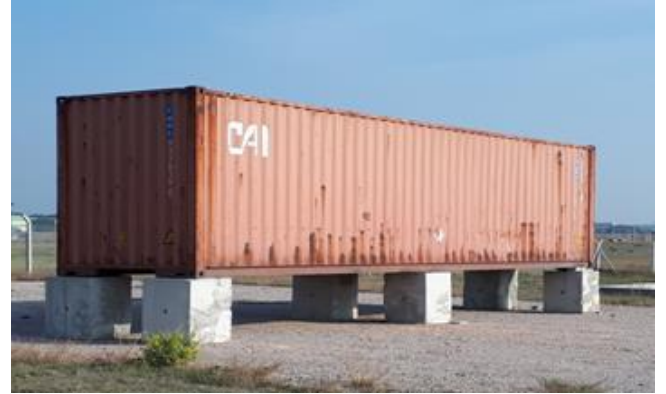
Şekil 5. Beton bloklar üzerine yerleştirilen konteyner [11].
