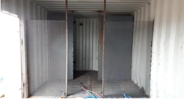
Şekil 7. Mutfak, tuvalet ve kokpit bölmelerinin yapım çalışmaları [11].
