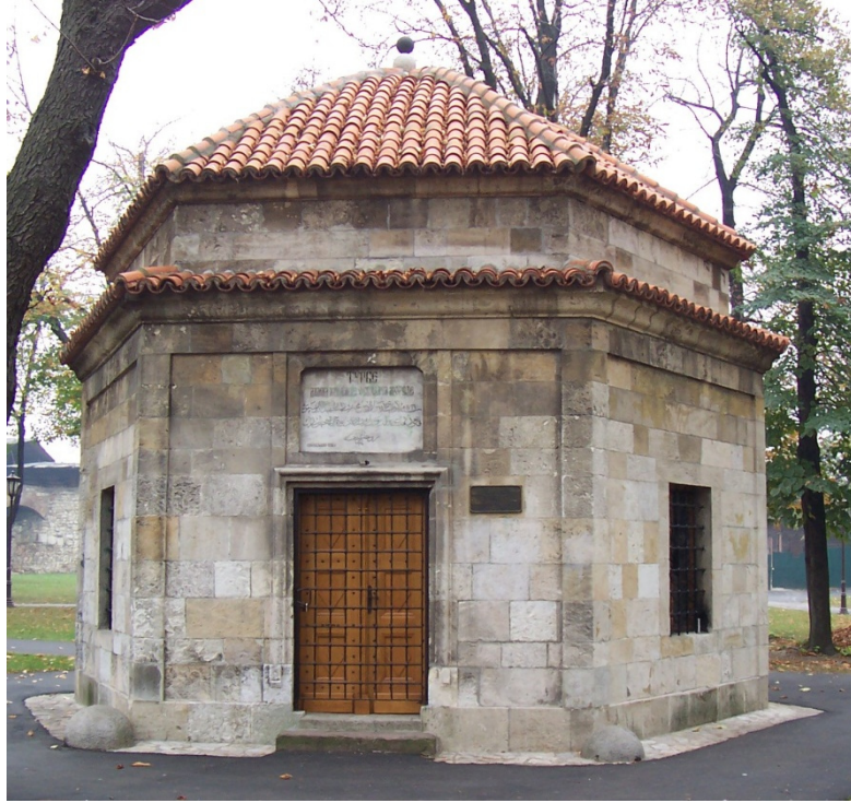
Belgrad Kaleiçi'nde Damat Ali Paşa Türbesi 1938 ve 2001 yıllarında onarılmıştır. (M.E.Yılmaz)
