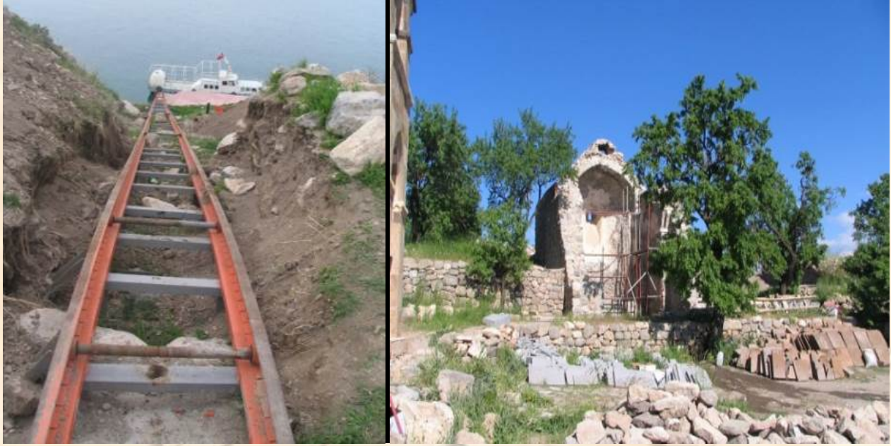
Fotoğraf 15,16. Akdamar Kilisesi Onarım Çalışmaları Görünüşleri (Ş. Öztürk)
