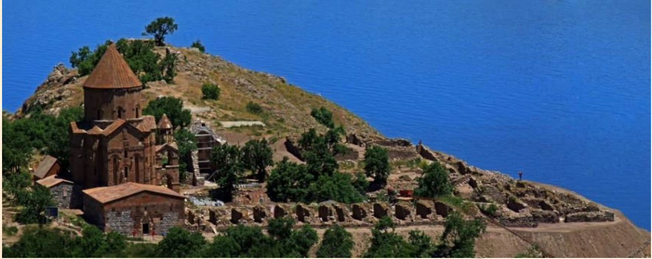
Fotoğraf 17. Akdamar Kilisesi Onarım Çalışmaları Genel Görünüşü (Ş. Öztürk)
