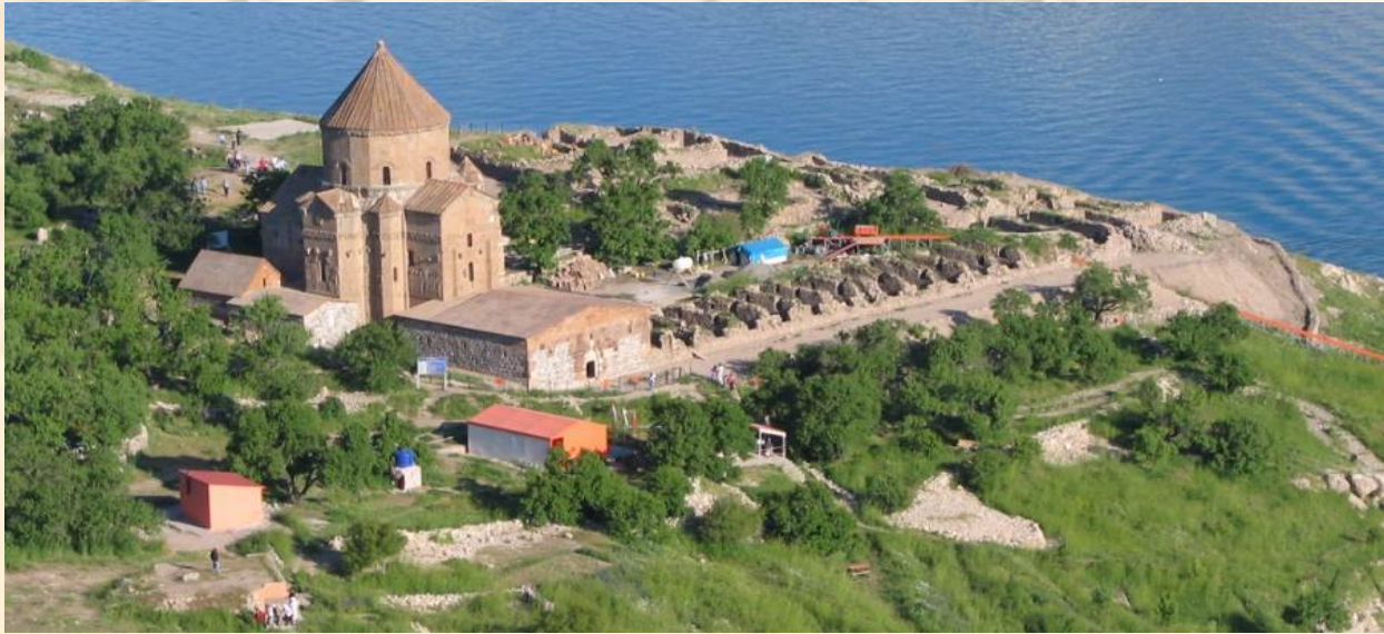
Fotoğraf 18. Akdamar Kilisesi Onarım Çalışmaları Genel Görünüşü (Ş. Öztürk)
