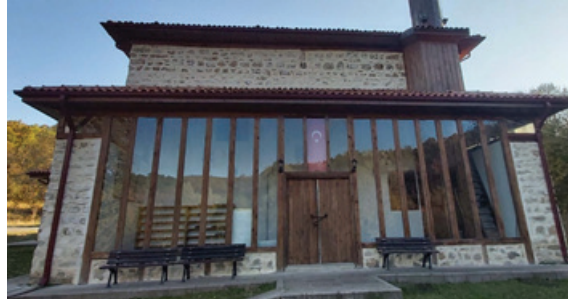
Şekil 5: Demirli Köyü Camii Son Cemaat Yeri
