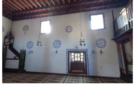
Şekil 31: Batı Duvarı Kalem İşleri (2012 Restorasyonu Sonrası)
