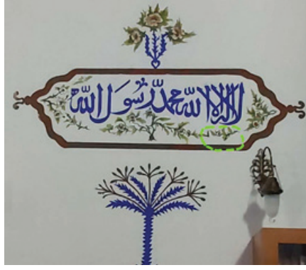
Şekil 26: Güney Duvarı Sıva Üstü Kalem İşleri (2012 restorasyonu Sonrası)
