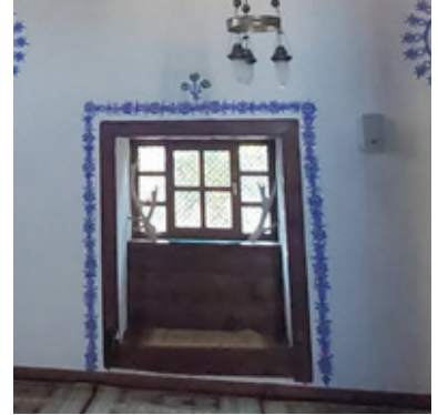
Şekil 35: Doğu Duvarı Pencere Kenarları Sıva Üstü Kalem İşleri (2012 restorasyonu sonrası)
