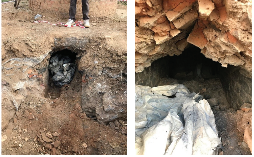
Şekil 8. Fil Fabrikası bacasında kazı sonucunda tespit edilen galeri
