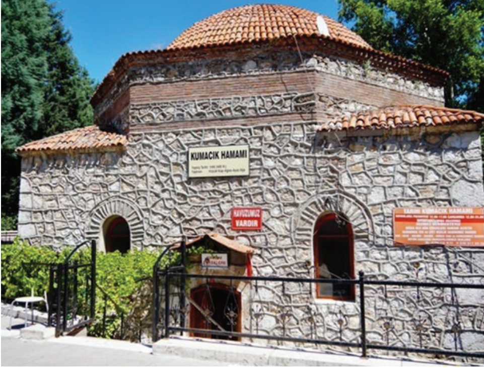
Fotoğraf 1. Amasya Kumacık Hamamı giriş cephesi
