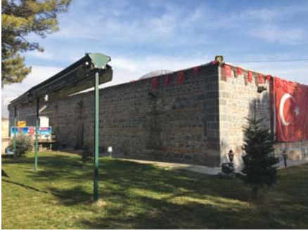
Foto 23. Taşçı hamamı batı cephe.
