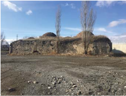
Foto 17. Nafiz Paşa hamamı doğu cephe.
