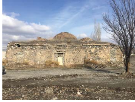
Foto 16. Nafiz Paşa hamamı güneydoğu cephe.
