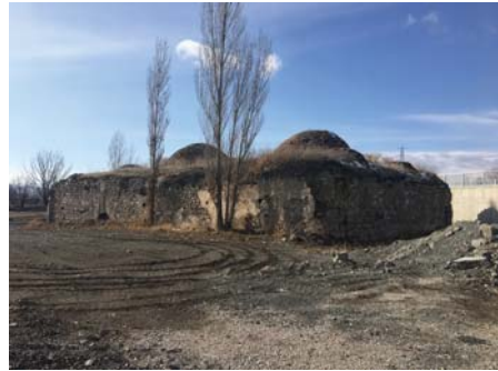
Foto 18. Nafiz Paşa hamamı kuzeydoğu cephe.
